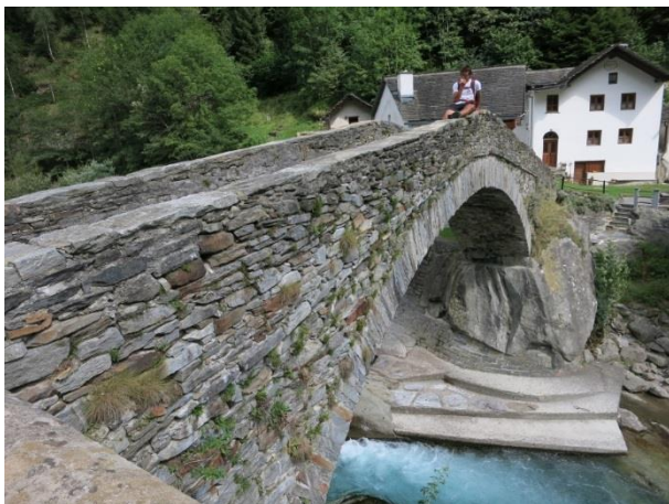
Immagine 30: Vista laterale del ponte ad arco in pietra sopra alla Calancasca ad Arvigo (Il ponte dell'amicizia / © Hansjürg Gredig)
