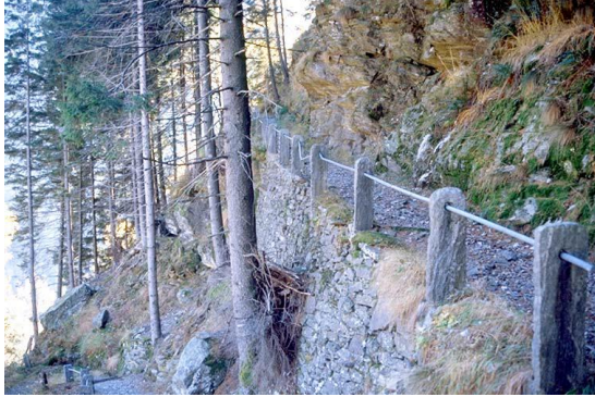
Immagine 32: Caratteristica tipica del sentiero con muri di sostegno a valle e parapetto sulla sponda boschiva ripida (© IVS)
