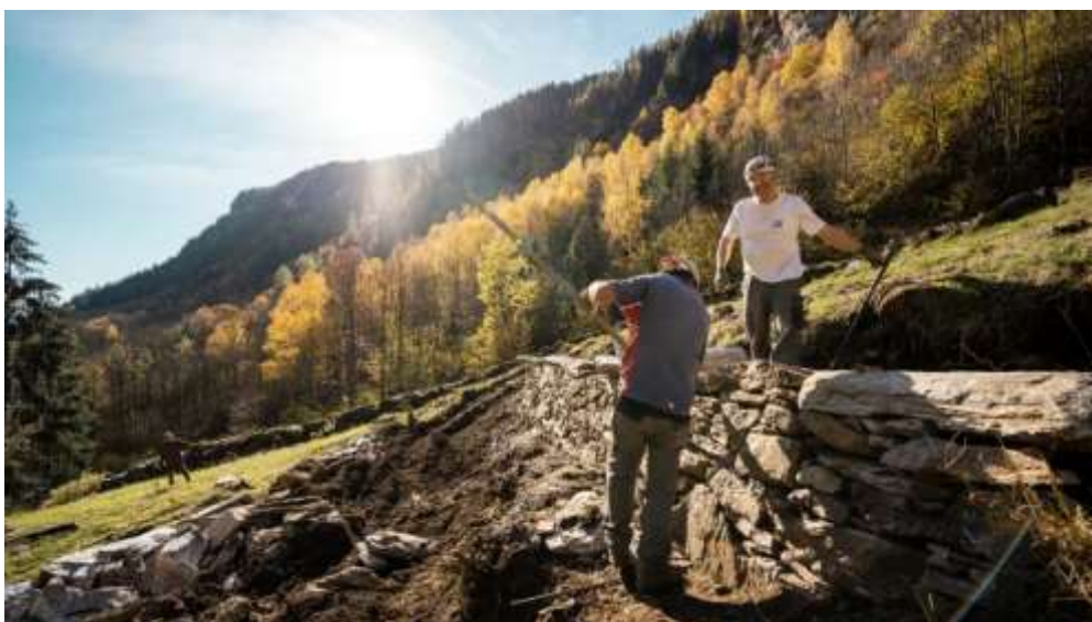
Foto 5: Il ripristino dei muri a secco. (Fonte: Svizzeraturismo)
