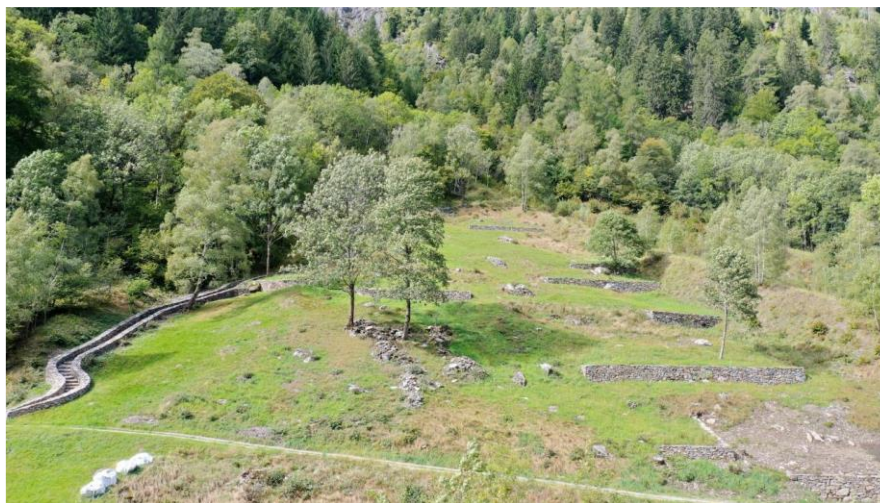
Foto 7: Il completamento dei lavori di recupero dei muri a secco terrazzati e del sentiero storico. (Fonte: O. Guscelli)
